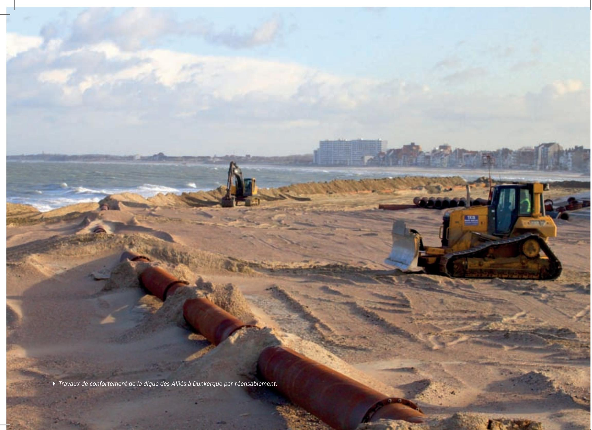
► Travaux de confortement de la digue des Alliés à Dunkerque par réensablement.
